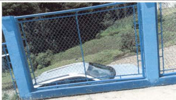
Foto 5: Reparación de malla
