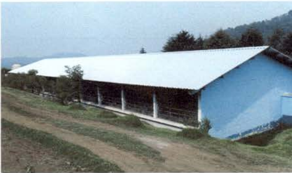
Foto 1: Sustitución de lamina
