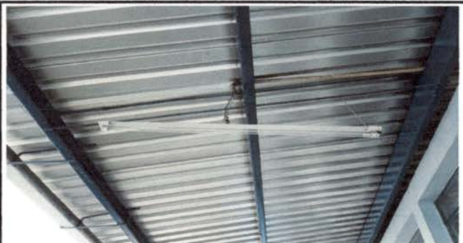
Foto 6: Sustitucion de focos ahorradores
