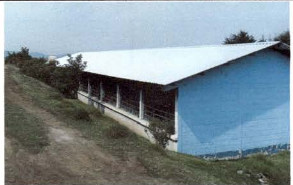
Foto 2: Sustitucion de Lamina
