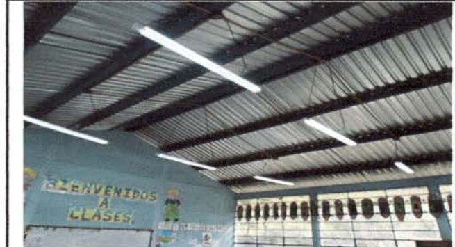
Foto 6: Sustitución de focos ahorradores
