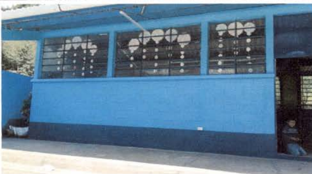
Foto 3: Sustitucion de Vidrios
