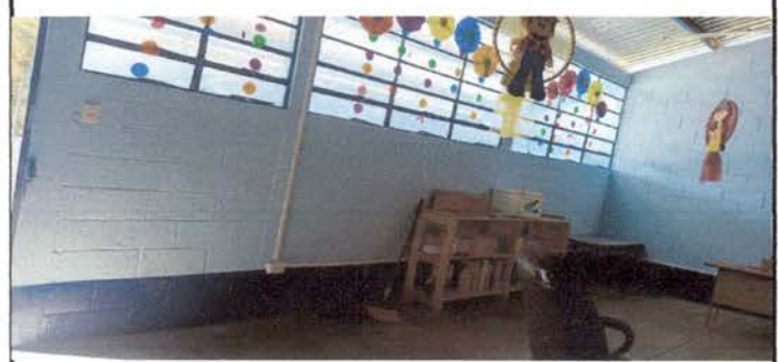
Foto 4: Pintura en Interior de las aulas
